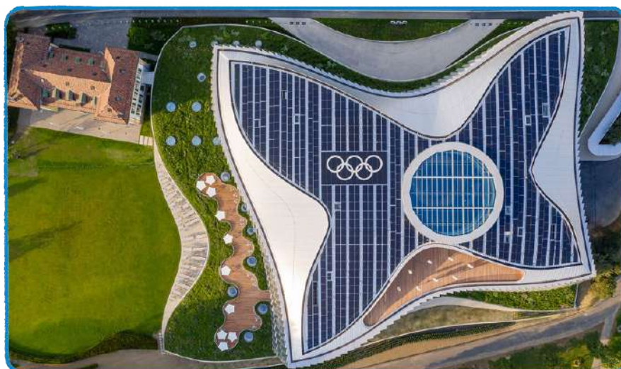
Vista aérea superior del edificio del C.O.I.
